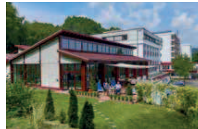
Außenansicht der Klinik
